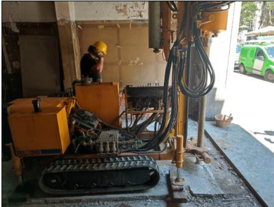
Ubicació sondeig geotècnic 4.
