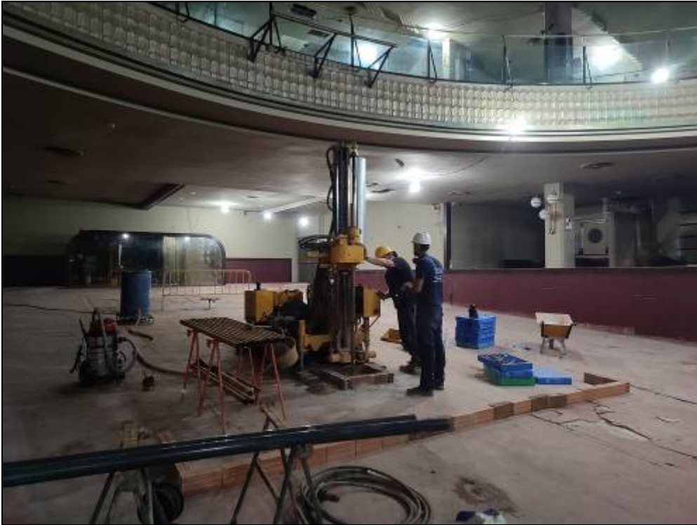
Ubicació sondeig geotècnic 2.
